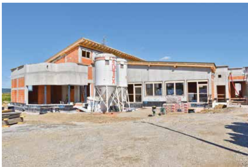
6. 6. 2022 - nova šola, vgrajena so že okna ...
